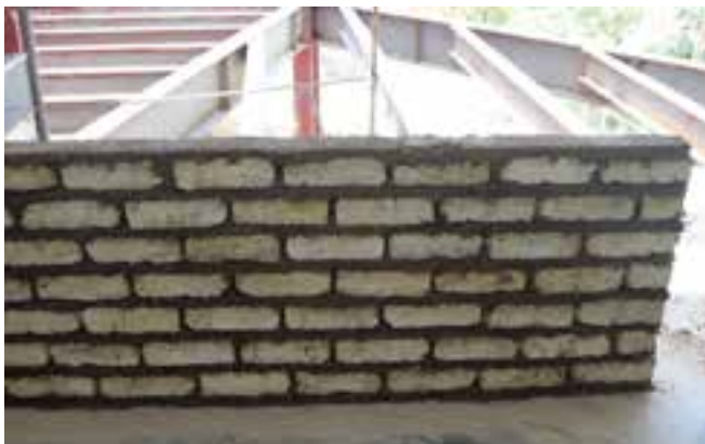
تصویر ۱۴ - دیوار نیم آجره (۱۱ سانتی‌متری)
