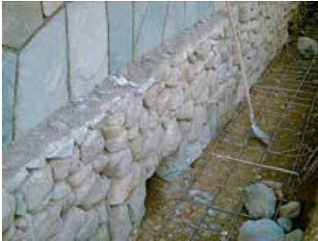
تصویر ۱- پی و دیوار سنگی
