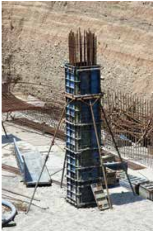
تصویر ۴ - قالب‌بندی فلزی ستون
