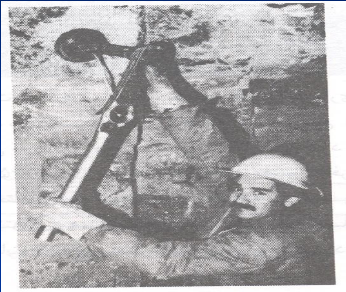
کشیدن سنگ دوز با سیستم هیدرولیکی در بارهای بیش از ۱۰ تن
