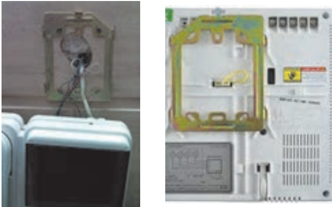
شکل ۱۱- پایه و نحوه نصب آن صفحه نمایش آیفون
