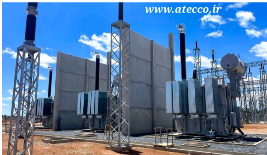
شکل (۶): سه ترانس تک فاز به عنوان یک مجموعه ترانس سه فاز
