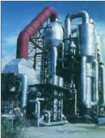
یک کارخانه‌ی تولید آب آشامیدنی از آب دریا که از فرآیند نمک زدایی استفاده می‌کند.
