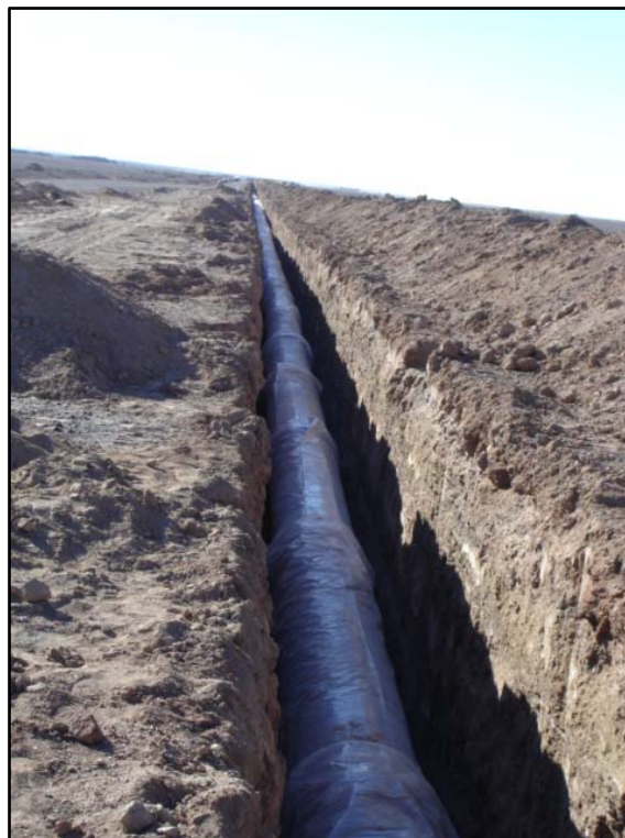
تصویر شماره (۳): اجرای پوشش پلی اتیلنی غیر چسبنده
