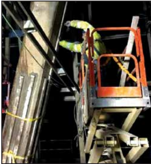
Fig. 5 Install Linear Anodes
