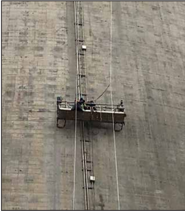
Fig. 30 Installing Conduit and Wiring
