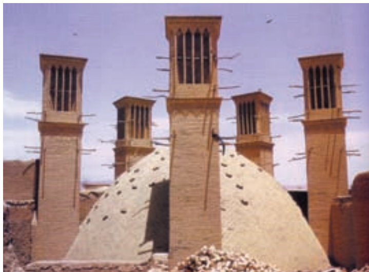
تصویر شماره ۲-۵۰- آب انبار و بادگیرهایش
