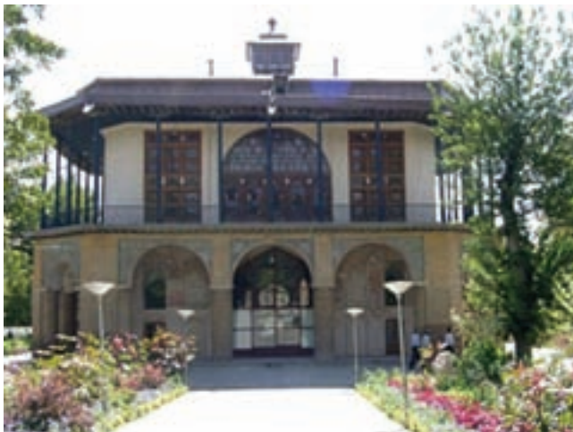
تصویر شماره ۳۳-۲ - بنای عالی قاپو در قزوین (صفوی)
