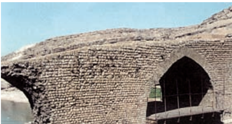
تصویر شماره ۱۸-۴ - پل دختر در نزدیکی اندیمشک مربوط به دوره ساسانی
