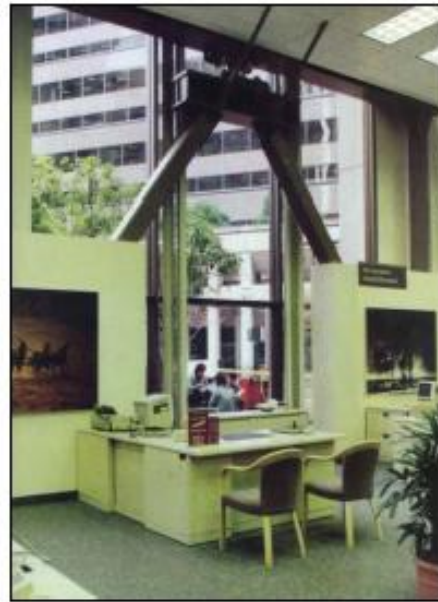
شکل ۷-۱۳- نمونه هایی از بکارگیری میراگر T-ADAS
