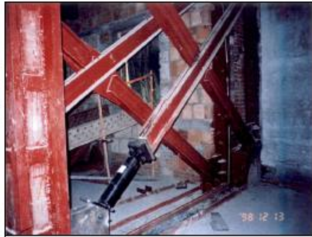
شکل ۷-۱۹- استفاده از میراگرهای ویسکوز در بادبندهای قطری
