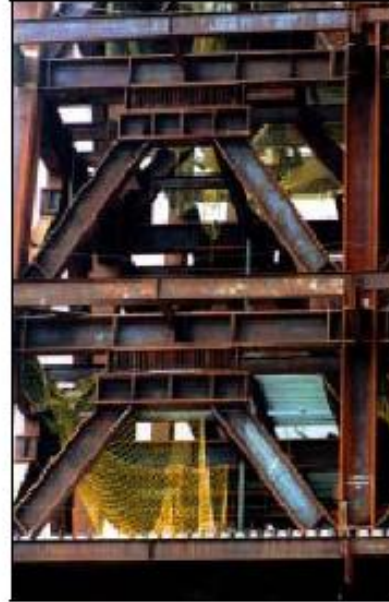
شکل ۷-۱۳- نمونه هایی از بکارگیری میراگر T-ADAS
