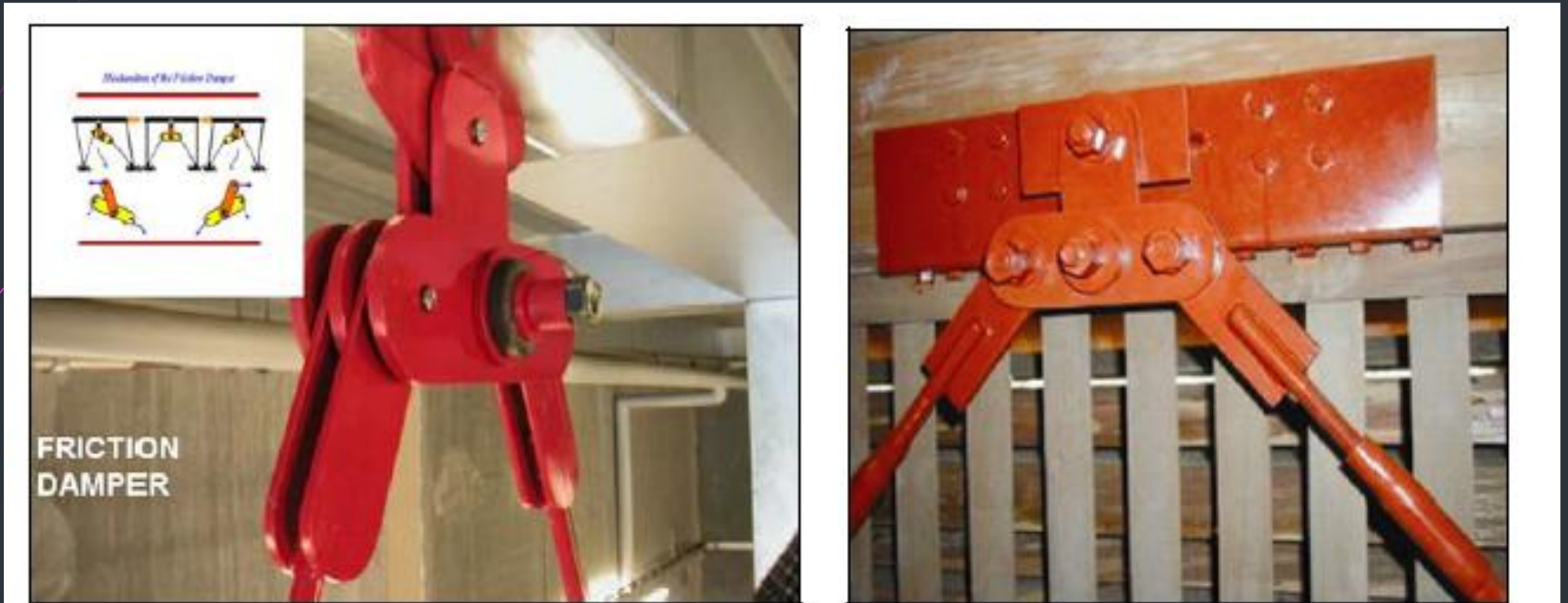
شکل ۷-۵- استفاده از میراگرهای اصطکاکی چرخشی در مقاوم سازی [۴]
