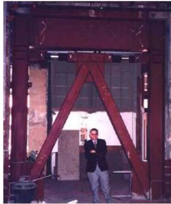
شکل ۷-۱۸- استفاده از میراگرهای ویسکوز در بادبندهای چنای
