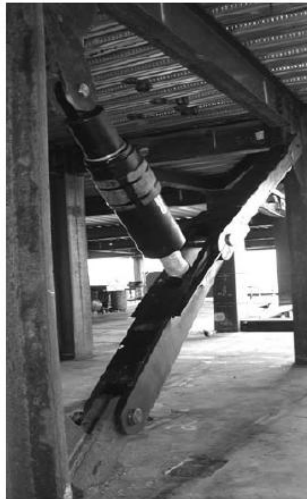
شکل ۷-۲۷- اشکال ترکیبی از نصب میراگر در ساختمان‌های بلند [۷]
