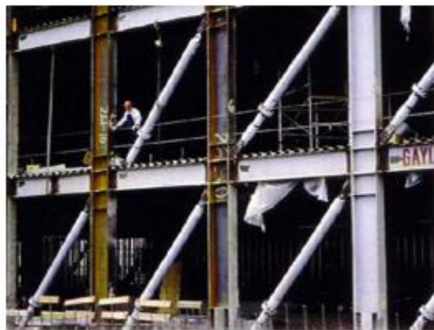
شکل ۷-۱۹- استفاده از میراگرهای ویسکوز در بادبندهای قطری
