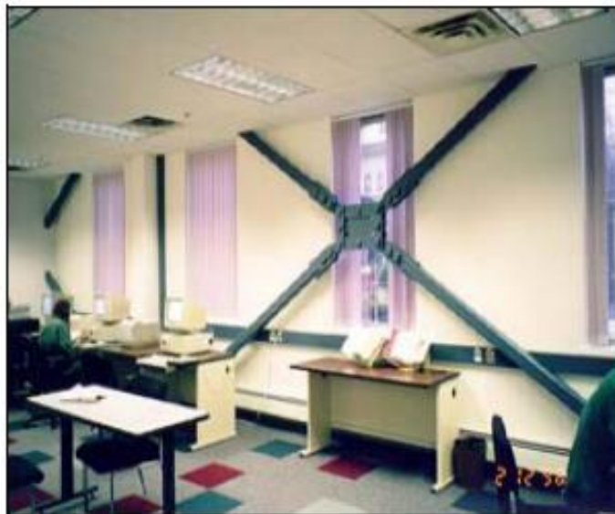
ادامه شکل ۷-۶- استفاده از میراگرهای اصطکاکی پال (Pall) در مقاوم سازی [۵]
