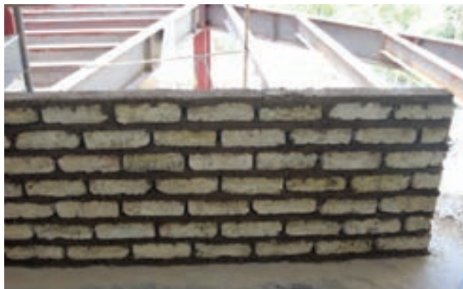
تصویر ۱۴ - دیوار نیم آجره (۱۱ سانتی‌متری)
