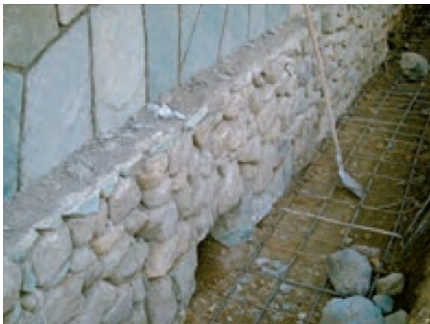
تصویر ۱- پی و دیوار سنگی
