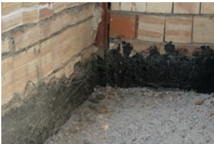
تصویر ۱۶ - عایق کاری کف سرویس بهداشتی
