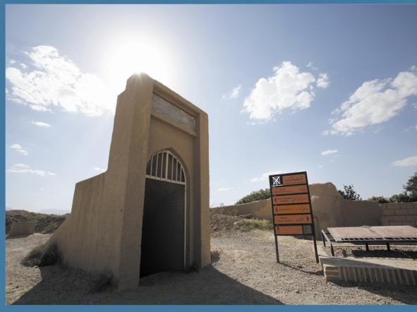
پایاب سازه ای است برای دسترسی آسان افراد به گذرگاه زیرزمینی آب قنات و یا عبارتست از کوره ای که به صورت مورب از سطح زمین به قنات گشوده شده و با پله هایی به کوره اصلی وصل می گردد که این حفره با شبکه ملائم از سطح زمین به کوره قنات ختم می شود. دسترسی مردم توسط پایاب به آب قنات در محلات فراهم می شده است که انواع پایاب شامل پایاب عمومی جهت دسترسی عموم به آب قنات و پایاب خصوصی که در منزل اشخاص ایجاد می شده است.
