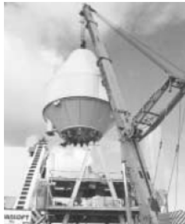
شکل شماره ۴-۳-۵ - دیگ بچینگ در حال نصب
