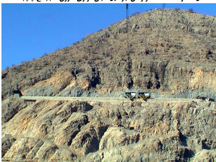
شکل شماره ۶-۶-۳- نمایی از واگن‌های جرثقیل کابلی موازی کارون ۳ (جناح راست)
