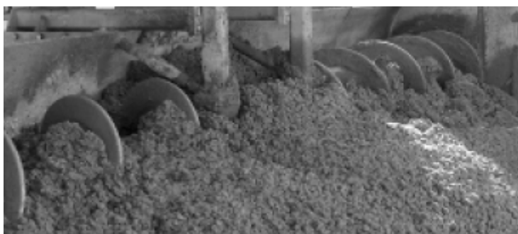
شکل ۴-۱۶-۸- پخش کردن بتن توسط تیغه ماریچ
