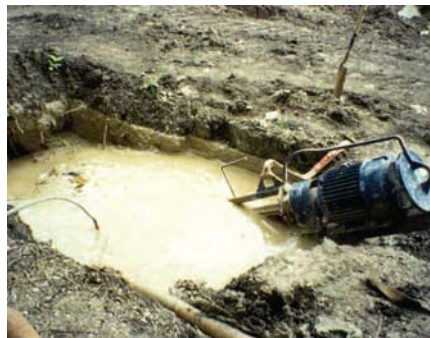
شکل ۳-۲۹-۵- گل حفاری در حال خروج از چال
