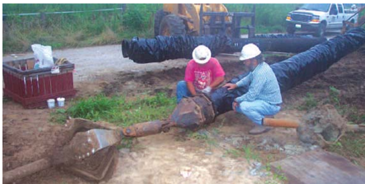
شکل ۳-۲۹-۷- نصب لوله به راد
