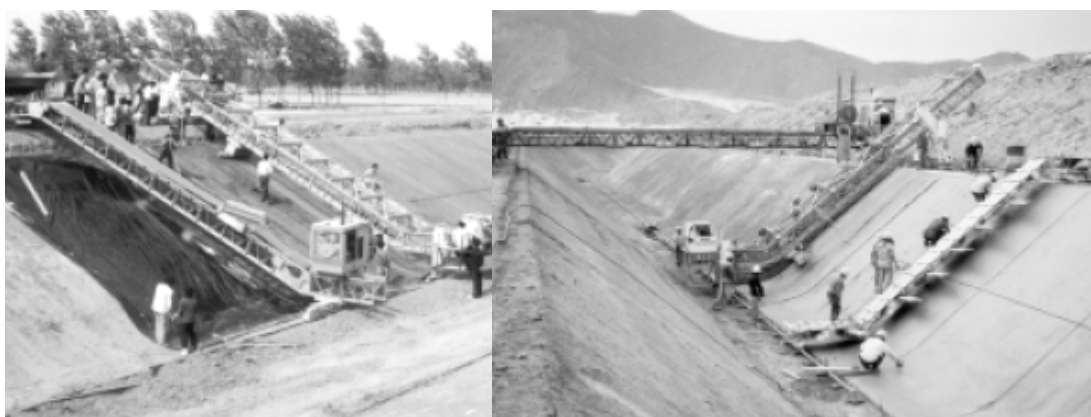
شکل ۴-۱۶-۴- استفاده از فینیشرهای سیلندری برای اجرای رویه بتنی کانال در کنار تجهیزاتی برای انتقال بتن و شیارزنی
