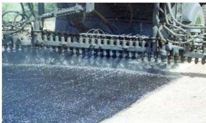
شکل شماره ۲-۲۰-۹- لوله پخش (spray bar)
