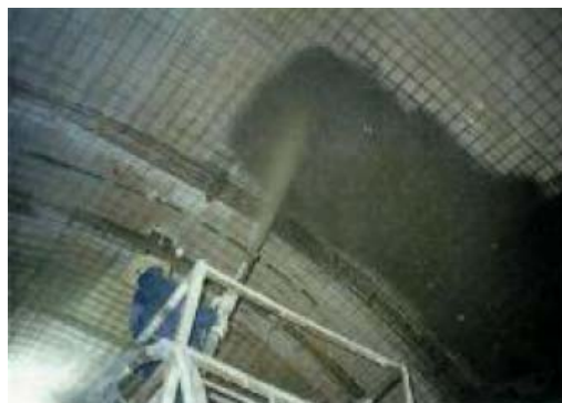
شکل ۴-۱۸-۲- استفاده از شاتکریت برای نگهداری فضاهای زیرزمینی
