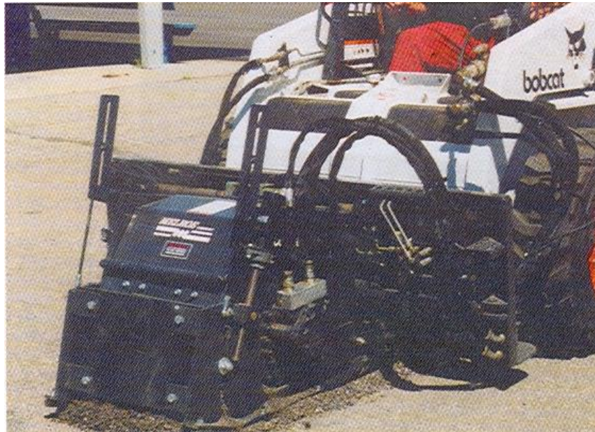
شکل ۲-۱۴-۱-۱- باب‌کت تجهیز شده برای تراش آسفالت
