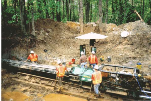
شکل ۳-۴-۷- استفاده از اوگر برای حفاری افقی
