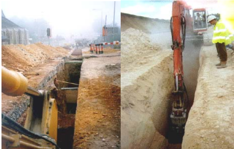
شکل ۳-۵-۳- کاربرد باکت حفار در حفر ترانشه
