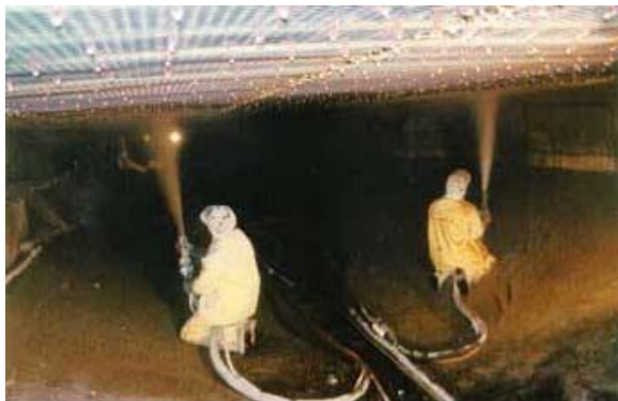
شکل ۴-۱۸-۱- نمایشی از کاربرد شاتکریت
