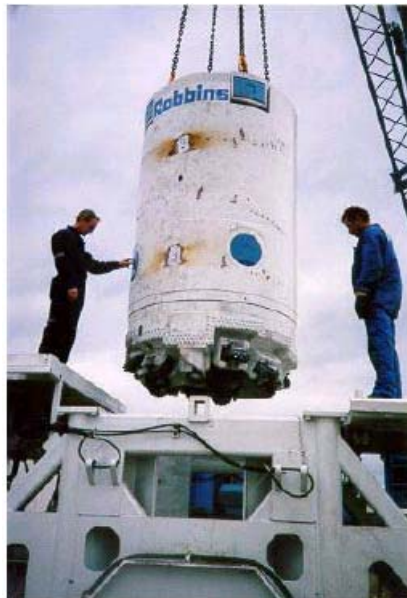
شکل ۳-۲۲-۳- نمای کلی از نصب ماشین در سطح زمین
