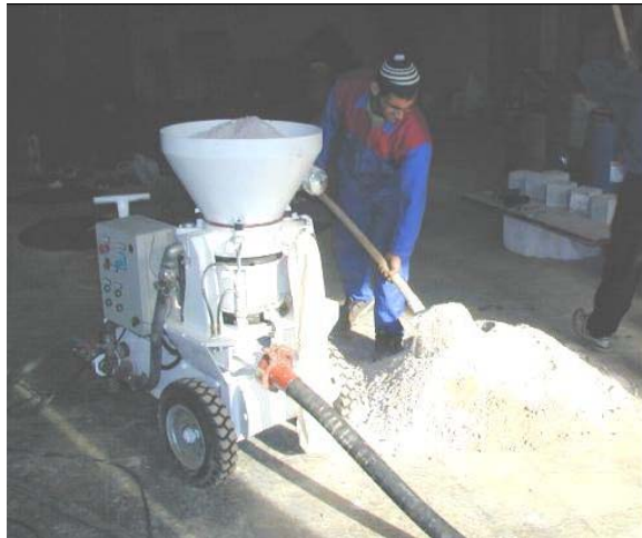
شکل ۴-۱۸-۴- نحوه ریختن مصالح در دستگاه پمپ شاتکریت
