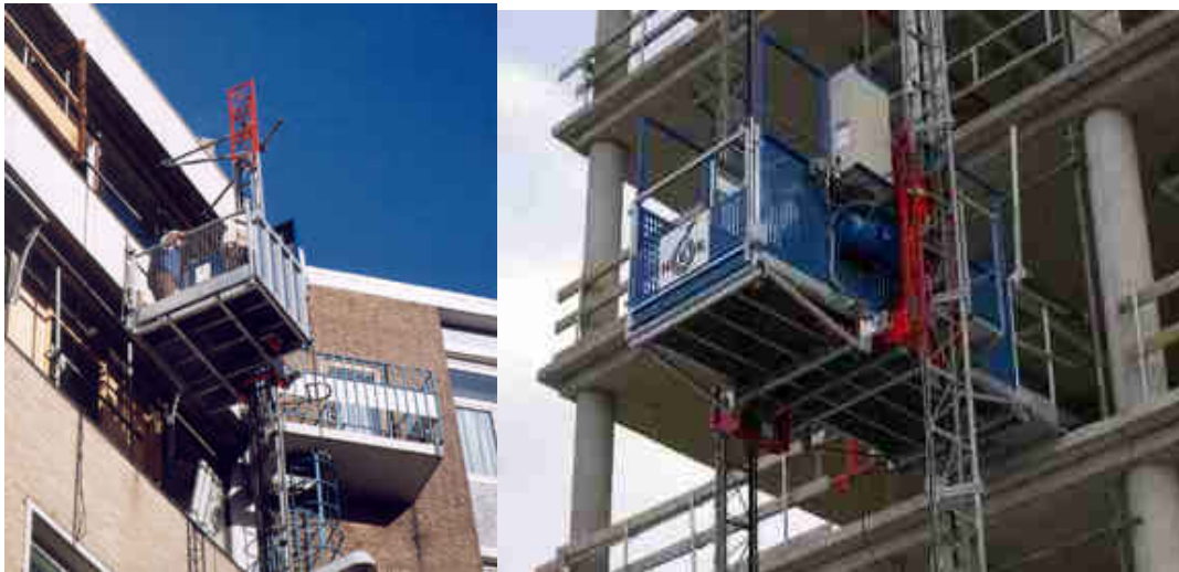
تصویر ۶-۱۰-۹- بالابرهاى حمل مصالح یک دکله
