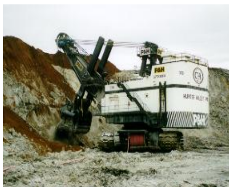
شکل ۳-۱۹-۲- شاول در حال عملیات لایه برداری
