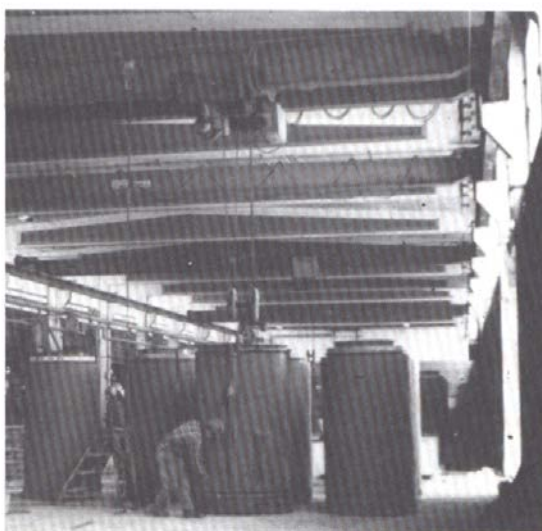
شکل ۴-۱۵-۷- جابه‌جا کردن لوله‌ها همراه با قالب محافظ
