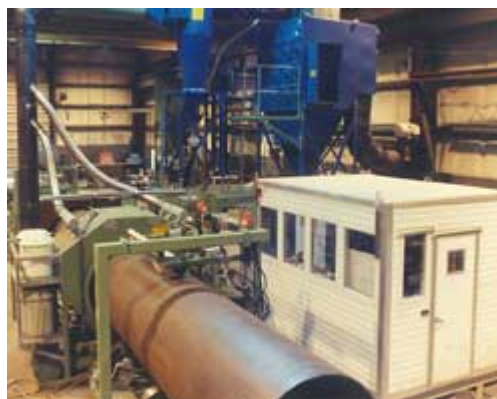
شکل ۵-۴-۷- کارگاه پوشش دهی
