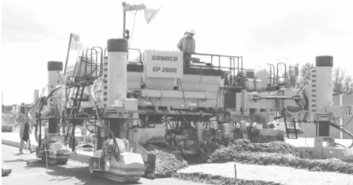
شکل ۴-۱۶-۱- نمونه ای از یک فینیشر بتن در حال روکش کردن راه
