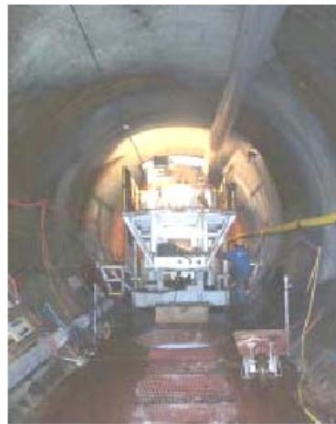
شکل ۳-۲۲-۲- نمایش ماشین نصب شده داخل تونل
