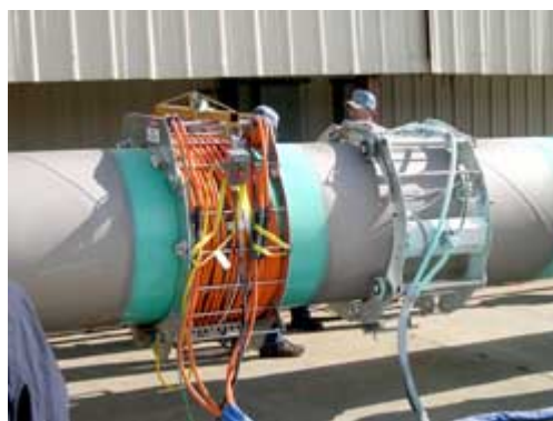
شکل ۵-۴-۸- سیستم پوشش دهی محل اتصال
