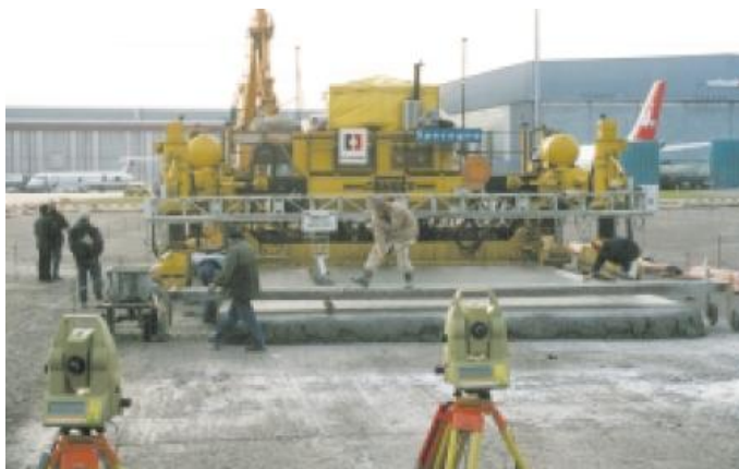
شکل ۲-۱۸-۹- استفاده از سیستم بدون سیم
