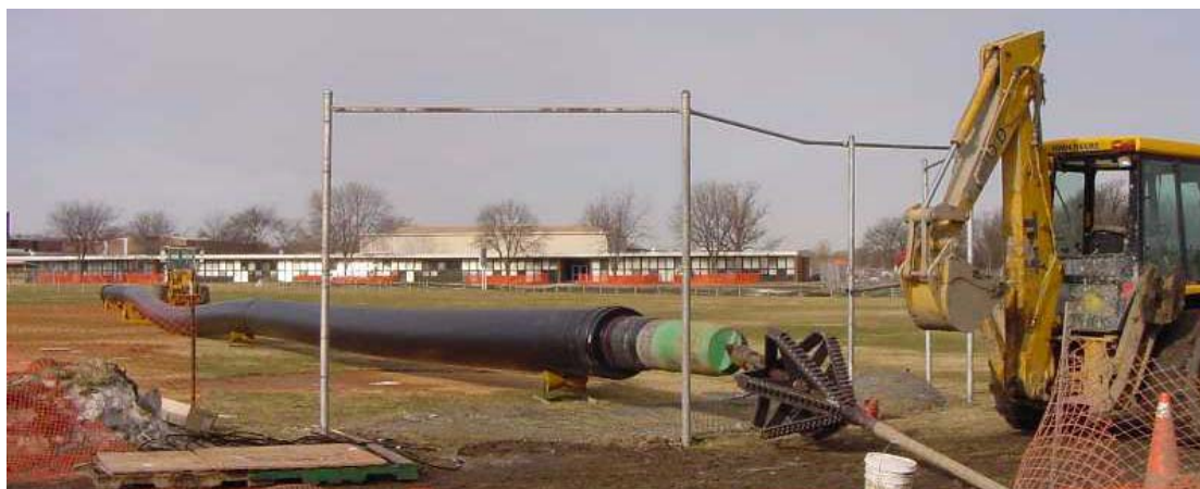
شکل ۳-۲۹-۸- لوله متصل به راد و آماده کشش
