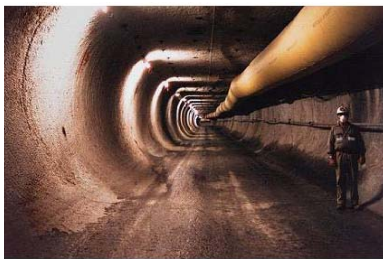
شکل ۲-۲۳-۳- نمایی از تونل حفر شده با ماشین Mobile Miner
