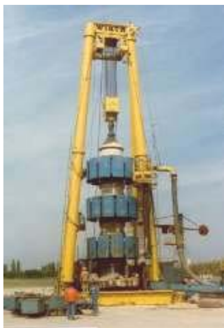
شکل ۳-۱۴-۱. نمایی از ماشین حفر چاه
