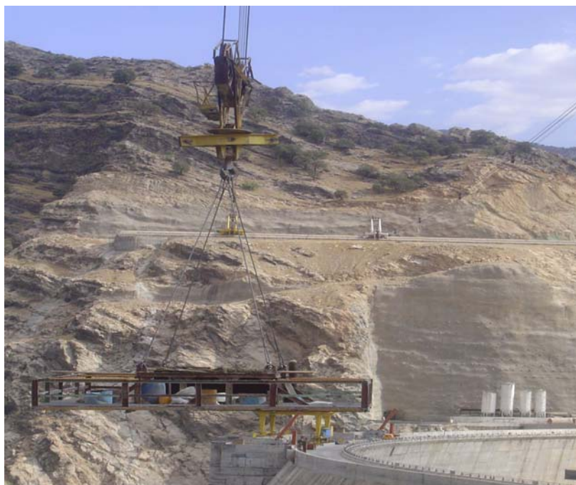
شکل شماره ۶-۶-۲- دو واگن جرثقیل کابلی موازی کارون ۳ (جناح چپ)
