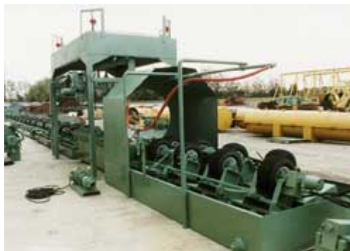
شکل ۵-۴-۹- کارگاه پوشش دهی خارجی با لعاب قیر
