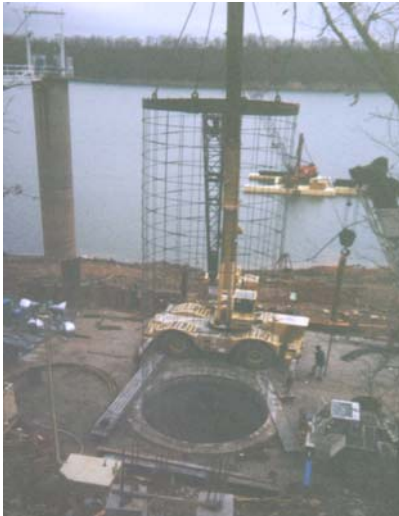
شکل ۳-۱۴-۶- نمایی از قرار دادن شبکه آرماتور در چاه
