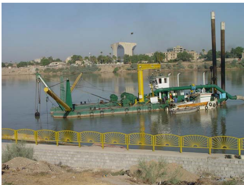
شکل ۵-۸-۱- لایروب در سطح رود کارون (منطقه اهواز)
