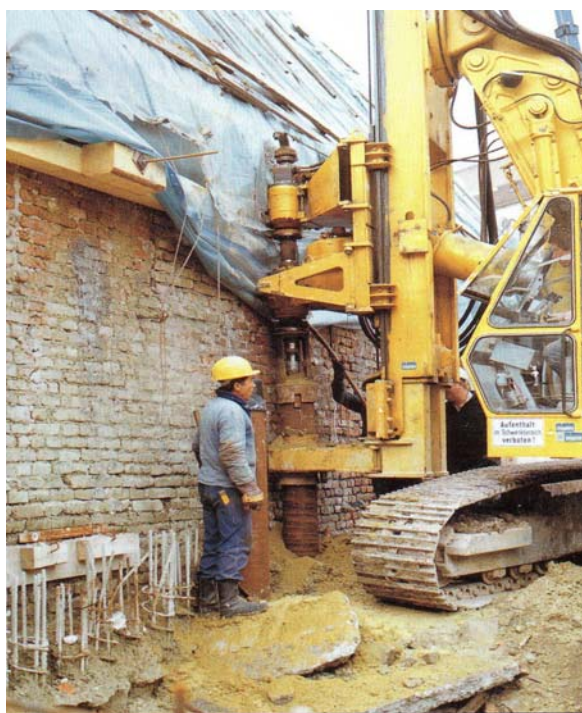
شکل ۳-۴-۱۰- حفاری با اوگر در مجاورت دیوار
