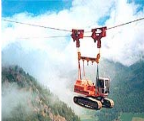
شکل ۶-۶-۱- جرثقیل کابلی در حال حمل بیل مکانیکی
