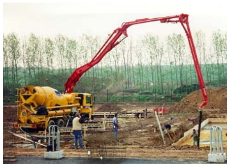
شکل ۴-۹-۸- پمپ بتن سوار شده روی تراک میکسر
