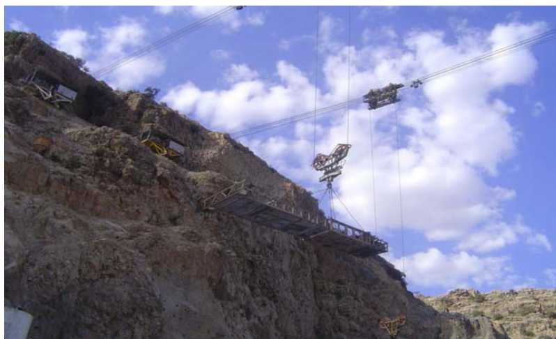
شکل شماره ۶-۶-۱۰- سیستم شاریوت جرثقیل کابلی
