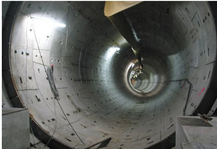
شکل ۳-۳-۳۸- مقطع نهایی تونل حفاری شده توسط تی بی ام با لاینینگ پیش ساخته
