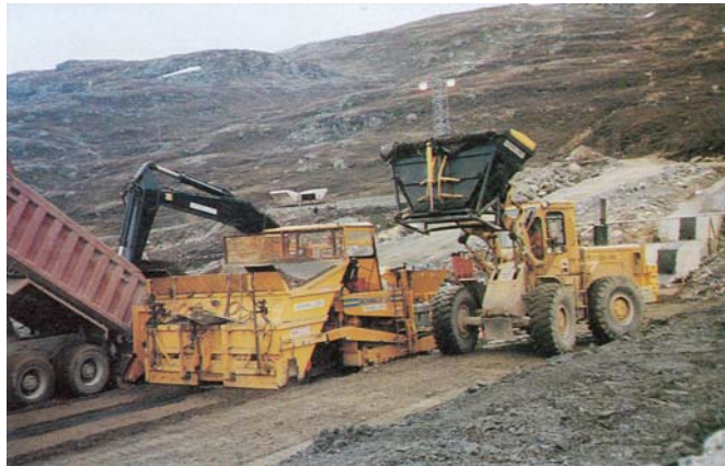
شکل ۲-۱۷-۴- بارگیری ماشین پخش مصالح سد هسته آسفالتی
