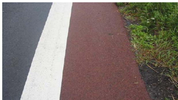
شکل شماره ۲-۲۰-۲- بازسازی شانه ها
