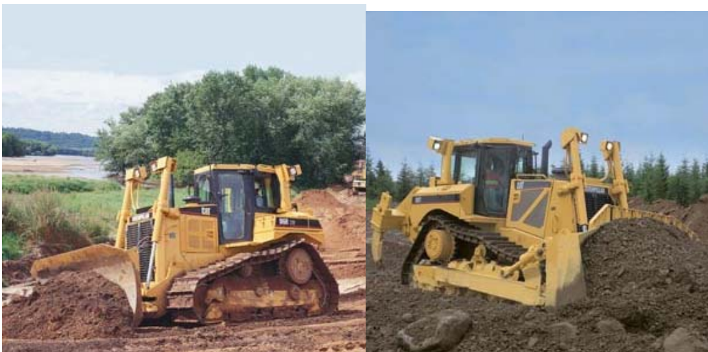
شکل شماره ۲-۲-۱- بولدوزر در حین عملیات خاکی
