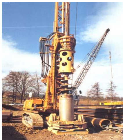
شکل ۳-۴-۶- استفاده از اوگر برای حفاری قایم
