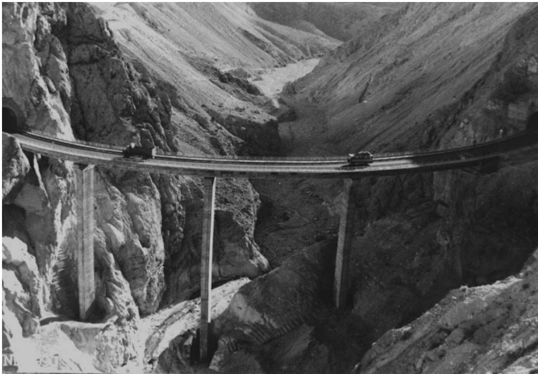
پل فورک در محور شیراز- بندرعباس
