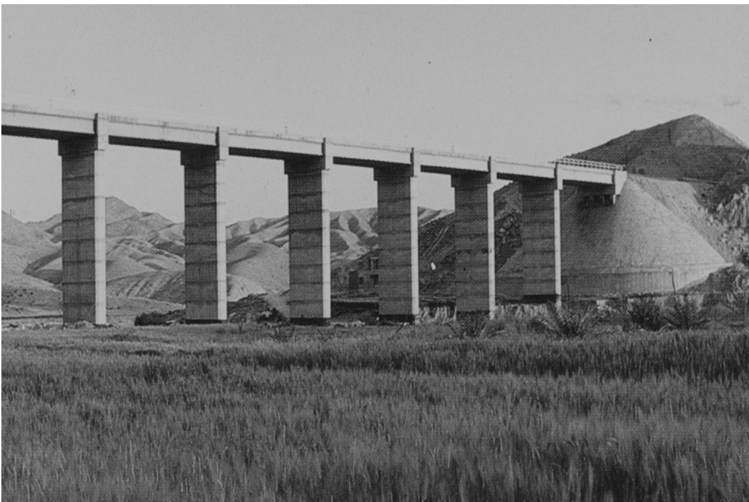
پل مسیر بافق - بندرعباس
