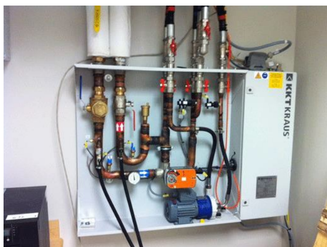
Figure ۶ لوله های آب چیلر
